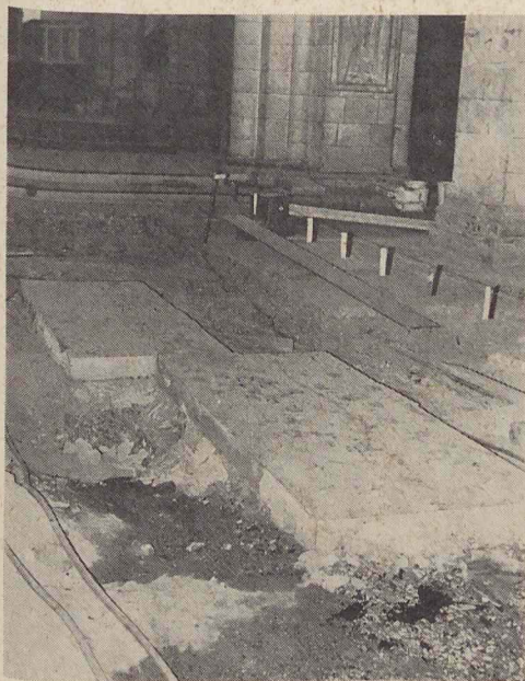
Auch der Fußboden wird erneuert. Nur die beiden Grabplatten der Bischöfe Bausch und Brand blieben erhalten.
